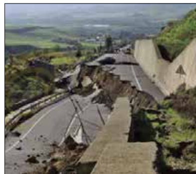
La frana di Montescaglioso
