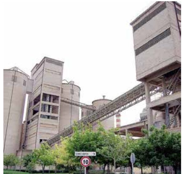
NEL CUORE DI UN PARCO Il cementificio in località Trasanello [foto Genovesi]
