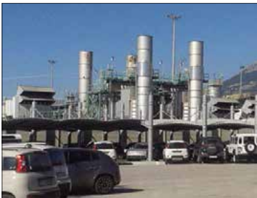
Il Centro Oli di Viggiano
