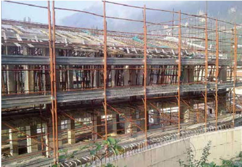
MARATEA La struttura ribattezza «ecomostro» nel centro storico della cittadina (anche sotto) Ora i giudici dicono: «Va abbattuto»
