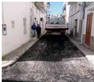
VIABILITÀ Lavori nel cuore della città
