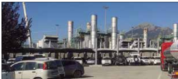
Il centro oli di Viggiano
