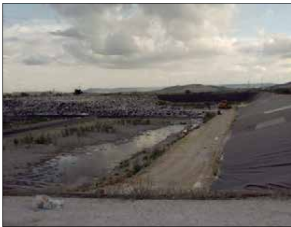
La discarica di La Martella al momento inattiva anche se andrà verificato, monitorato il percolato che dovrà essere aspirato viste anche le condizioni meteo delle passate settimane
