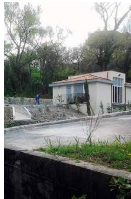
CENTRALE IDROELETTRICA L'impianto di Maratea
