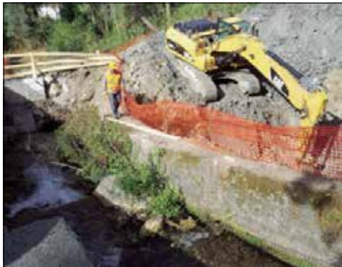
Una foto dell'epoca dei lavori per la centrale a Fiumicello
