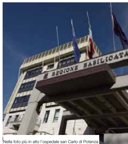
Nella foto più in alto l'ospedale san Carlo di Potenza. Sopra il palazzo della Regione Basilicata
