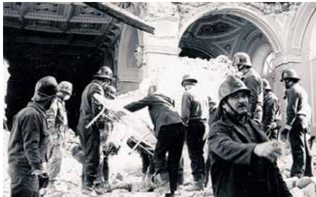
SISMA Balvano subito dopo il disastro del 23 novembre 1980 [foto Tony Vecce]
