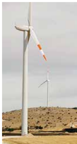
PALE EOLICHE L'impianto è in via di ultimazione, ma due dei piloni installati sono visibili dal centro abitato
