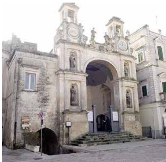
CANTIERE MUSICALE La sede centrale del Conservatorio Duni in piazza Sedile [foto Genovesi]
