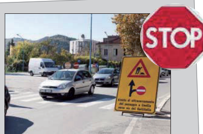
La segnaletica lungo viale del Basento, all'altezza dell'ingresso al Conad: il passaggio a livello impraticabile
