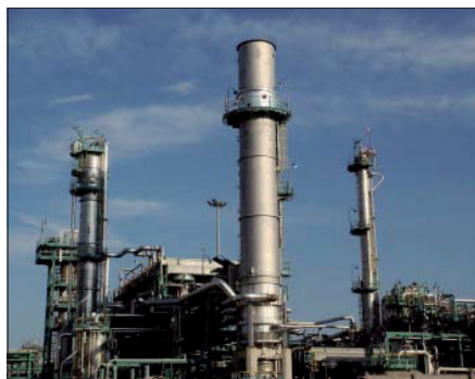
Il Centro oli di Viggiano
