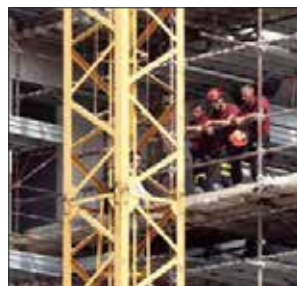
Un cantiere edilizio
