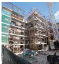
CANTIERE Pal. d'Errico (foto Vecce)
