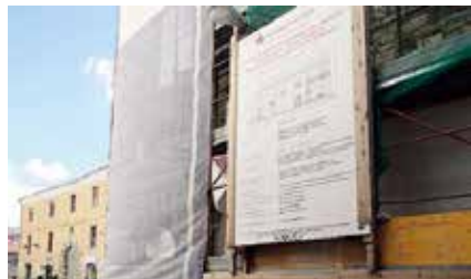
CANTIERE Proseguono i lavori a palazzo d'Errico [foto Tony Vecce]
