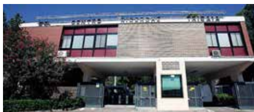
CENTRO RICERCHE TRISAIA L'ingresso situato a ridosso della strada statale 106
