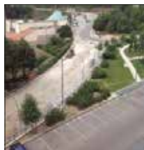
La viabilità modificata a Poggio Tre Galli per i lavori
