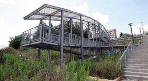
A COSA SERVE? L'opera realizzata a Poggio Tre Galli [foto Tony Vecce]
