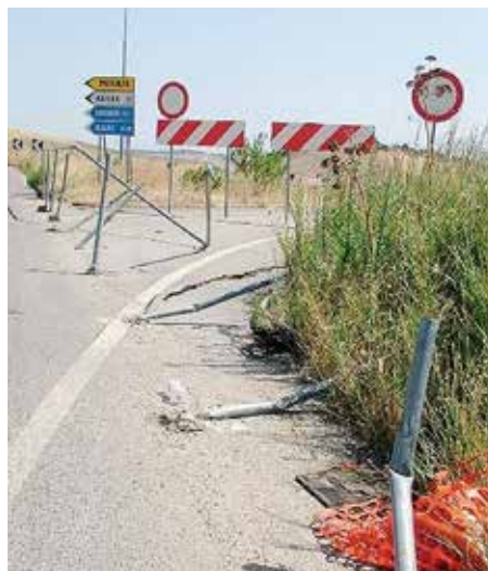
CANTIERE Interruzione per la Bradanica. Sotto, l'ultima riunione in Prefettura
