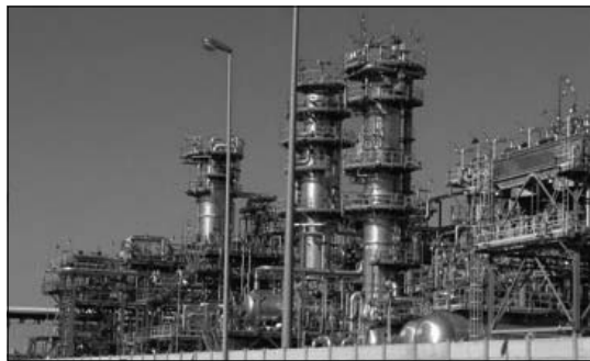
Il Centro oli di Viggiano
