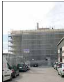
L'altro cantiere in via Tacito
