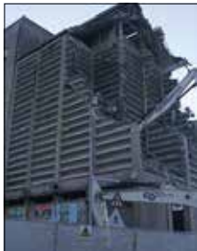
La demolizione dei silos mesi fa al Mulino Alvino
