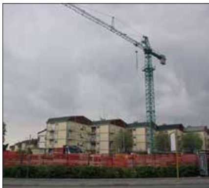
Il cantiere della Cogem in via Dante (foto Martemucci)
