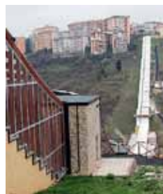
LUNGO Il ponte attrezzato
