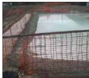
Una delle vasche nel cantiere
