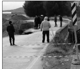
Il ponte crollato tra Craco e Pisticci
