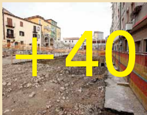
CANTIERE L'intera area «ostaggio» dei lavori per i box-auto interrati [foto Tony Vecce]
