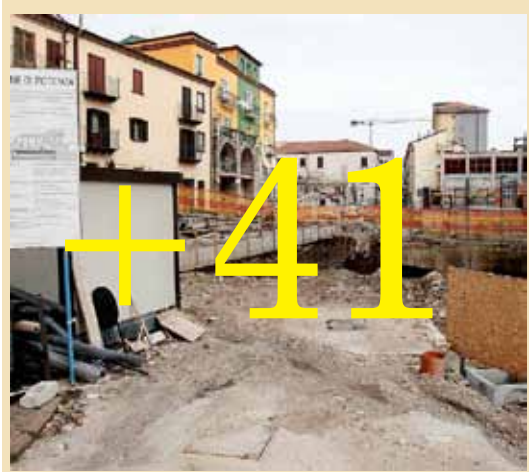
CANTIERE L'intera area «ostaggio» dei lavori per i box-auto interrati [foto Tony Vecce]
