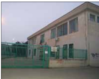
La scuola elementare di via Bramante
