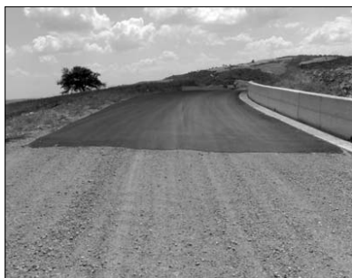
Un tratto della Cavonica
