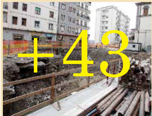
CANTIERE Fermi da tempo i lavori per i box-auto [foto Tony Vecè]
